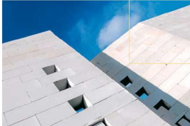
Los bloques de hormigón celular YTONG son piezas que cumplen con la normativa UNE EN 771-4:2000 (Especificaciones de piezas para fábrica de albañilería Parte 4: Bloques de hormigón celular), normativa referenciada en el CTE, siendo su cumplimiento requisito para obtener los certificados CE.
