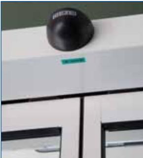
Las puertas automáticas de GEZE incluyen, de serie, un sistema de batería monitorizada con autodiagnóstico que garantiza la apertura en caso de emergencia según CTE.
