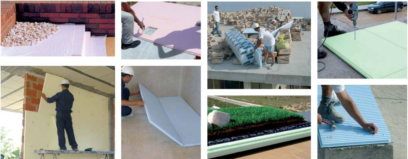
**Aislamientos Termo-Acústicos** gama TR elaborados a partir de poliestireno expandido elastificado (EEPS) con partículas de grafito para mejorar el componente térmico y acústico del aislamiento. **TR-0** para cerramientos que requieran un buen aislamiento térmico con un componente acústico ( $\lambda=0,033 / 50$  dB). **TR-5** para cerramientos que requieren un buen aislamiento acústico y que además sume un buen componente térmico ( $\lambda=0,033 / 58$  dB).
