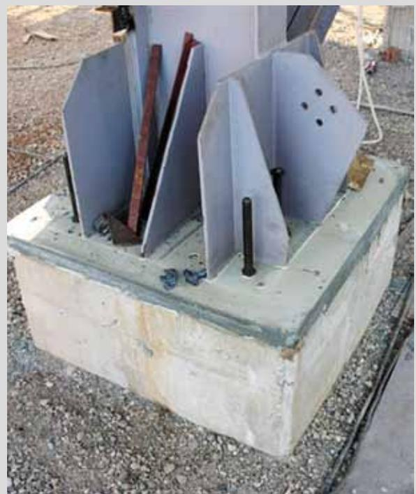
Nivelación con MORCEM GROUT 500 en Planta Biodiesel
