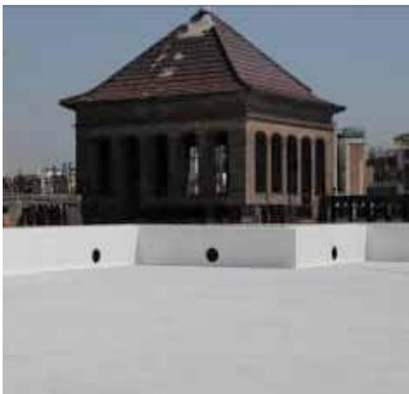
Cubierta plana impermeabilizada con MORCEM COVER
