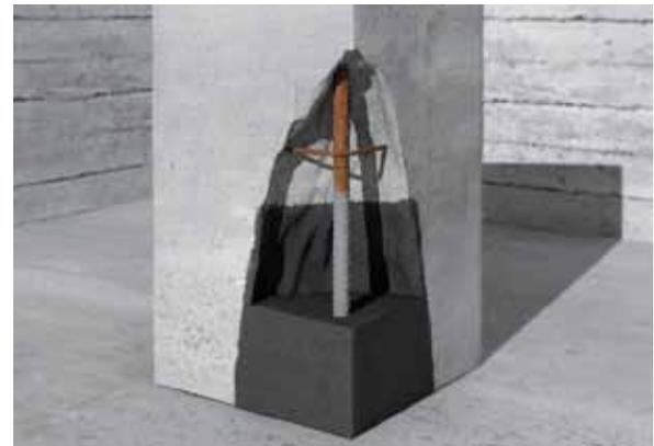
**Reparación mediante mortero tixotrópico**
