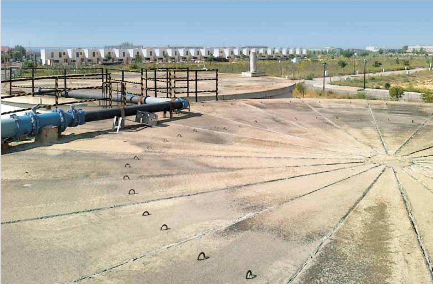
Impermeabilización de cubierta de depósito mediante tratamiento de juntas con MEMBRANA ELÁSTICA H
