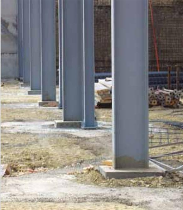
Detalle de nivelación y relleno bajo placa de estructura metálica
