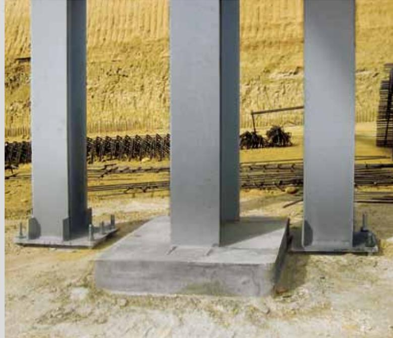
Detalle de nivelación y relleno bajo placa de estructura metálica
