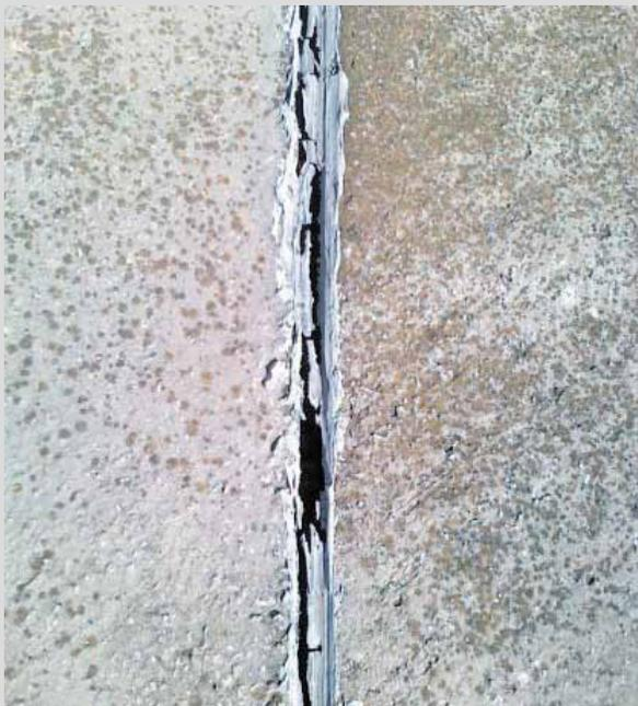
Detalle de junta de cubierta de depósito con sellado deteriorado con el tiempo
