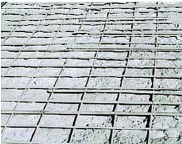
Picado mediante hidrodemolición
