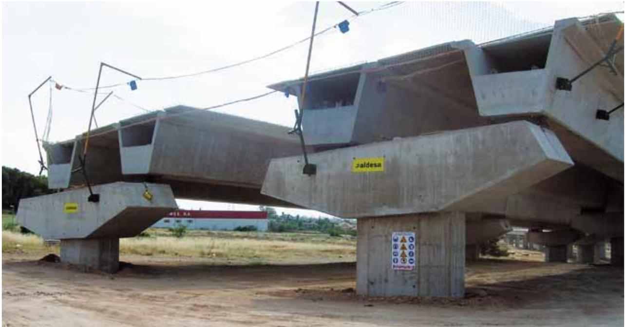
Detalle de apoyos de neopreno nivelados con MORCEM GROUT 500 en la MU-31 (Murcia)
