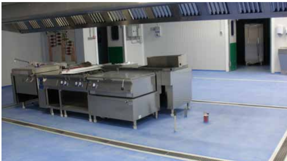
Cocinas en nuevas instalaciones Catering Las Torres – Ucrete DP 10 (4mm).
