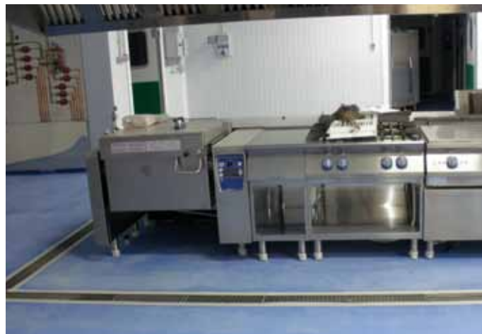
Acabado Sistema Ucrete DP 10
