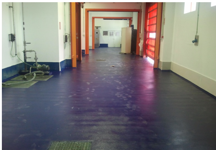
Pavimentos epoxy MasterTop 1273 R en zona de envasado.
