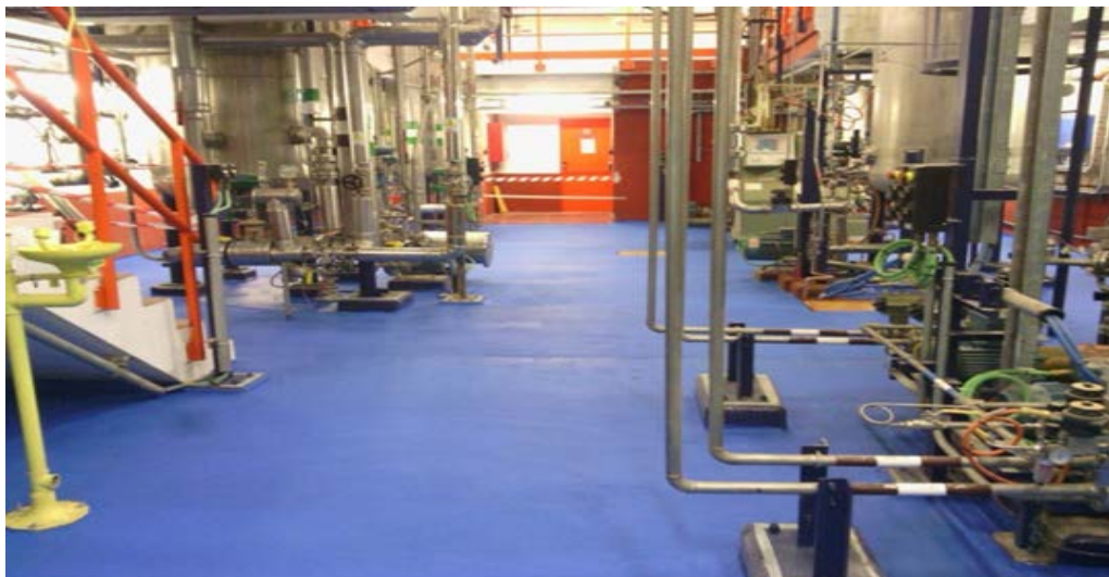
Zona de formulación repavimentada con Sistema Ucrete DP 10 AS
