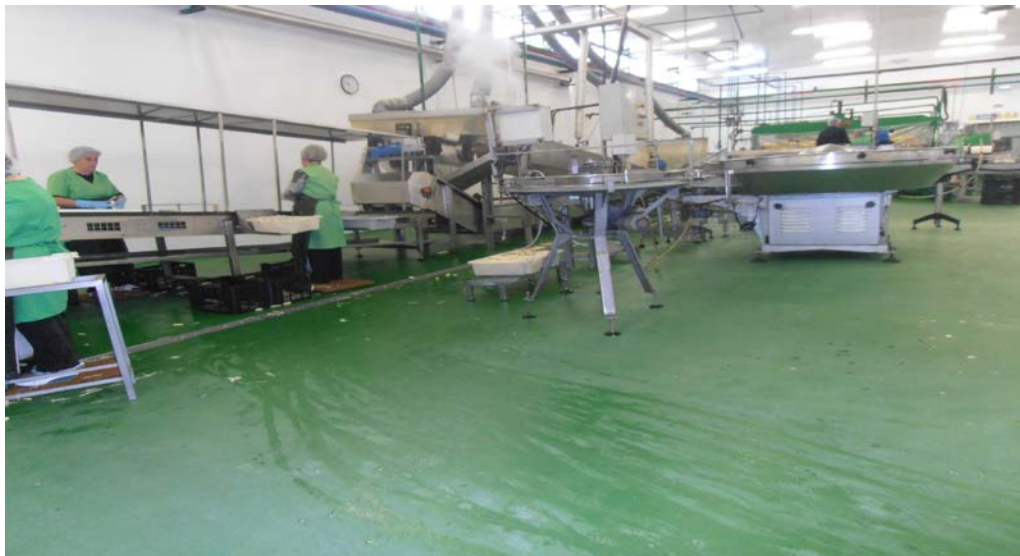
Sala de producción con nuevo pavimento Ucrete DP 10
