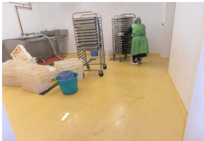
Pavimentos con Ucrete DP 10 en sala destinada a cocina
