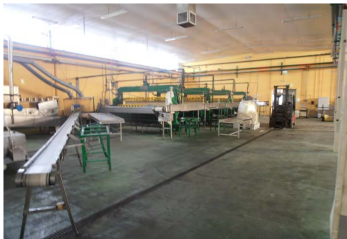
Estado del pavimento antes de la rehabilitación
