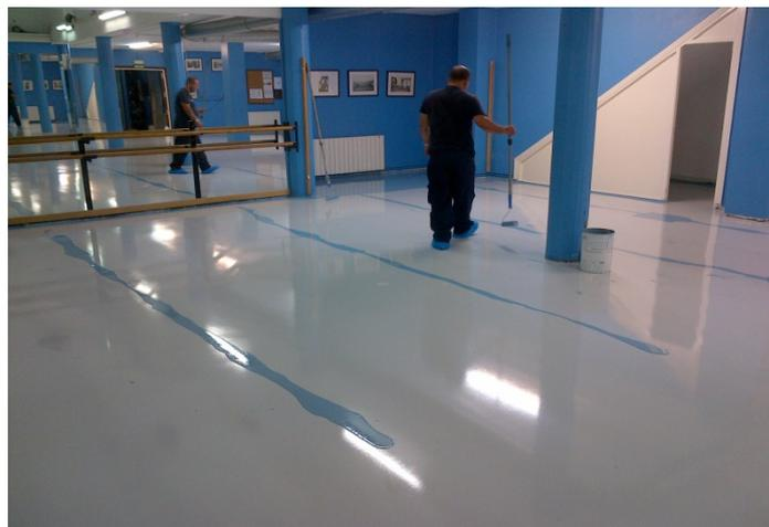
Sellado del pavimento con resina de poliuretano mate en base agua
