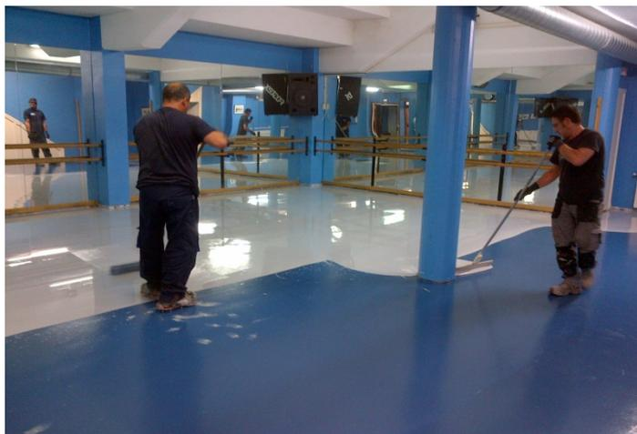
Aplicación de capa autonivelante sobre base confortable amortiguadora de ruidos de impacto
