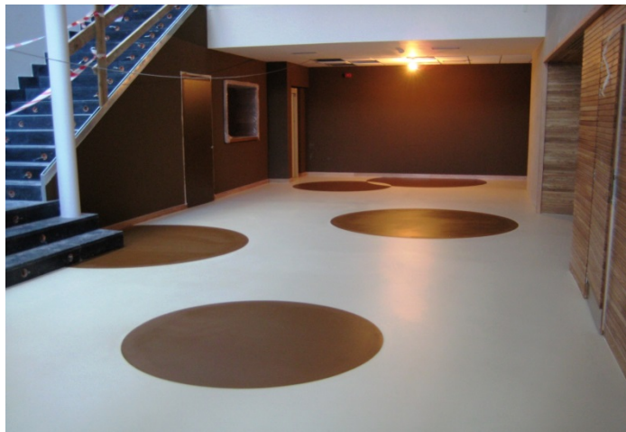
Hall de acceso con pavimento decorativo MasterTop 1325
