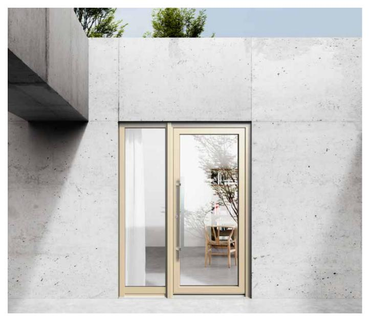
↑ Las puertas de entrada con grandes transparencias deberían estar equipadas con vidrios de protección solar, capaces de reducir significativamente la entrada de calor.
