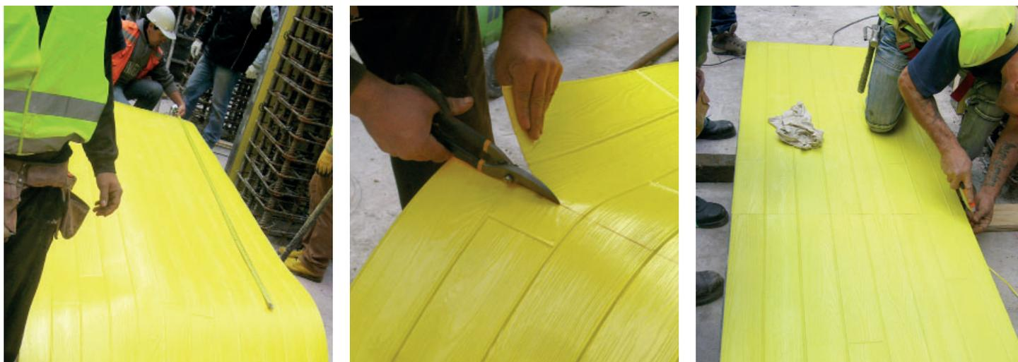
3.- Para la fijación del **LHV Formliner** se pueden utilizar diferentes técnicas.
