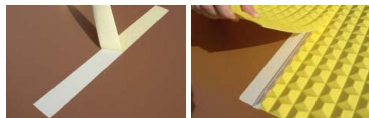
4.- Utilizar siliconas transparentes o blancos para el sellado de uniones y contacto con el hormigón, siendo conocedores de la marca que quedará registrada en el hormigón.
