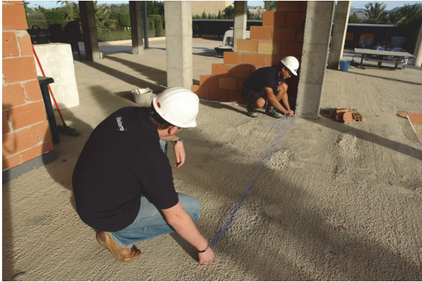
1- Replanteo en obra
