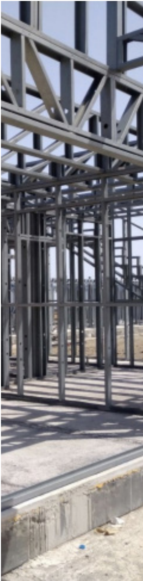
Primera fase del proceso constructivo con Light Steel Frame
