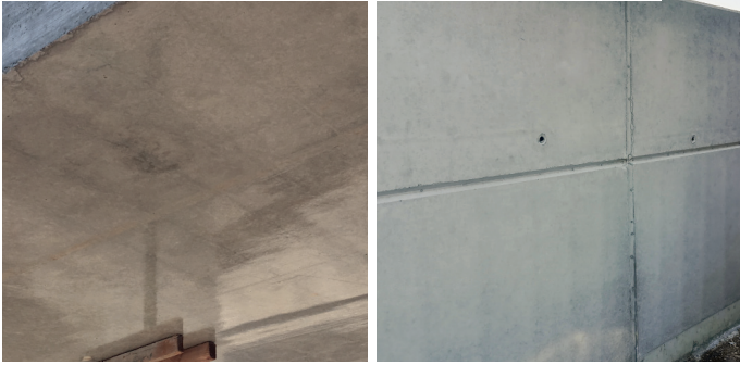
Acabados superficiales lisos hormigonado "in situ"
