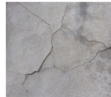
Se debera comprobar la adherencia al cerramiento de los morteros hidráulicos y revestimientos cerámicos existentes. En la comprobación, toda zona que presente fisuraciones por fallo de adherencia, o sonido hueco al golpear, se deberá de eliminar y reparar.
