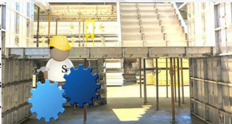
Los **paneles pesan tan solo 16 kg por m2**, haciéndolos manportables en su operación, facilitando así la secuencia de armado y desencofre.
