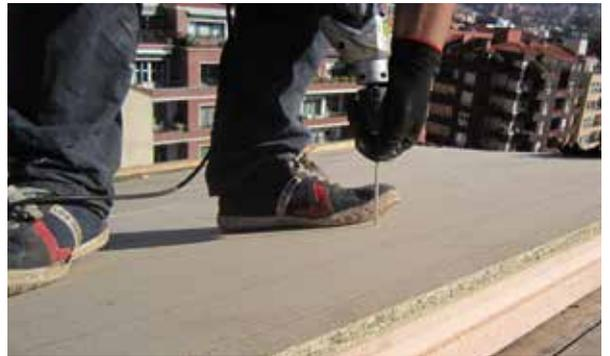
■ El ensamblado de los paneles se realizará por medio del **encaje macho-hembra** del aislamiento. Los paneles **nunca deben de volar**, siendo recomendada su **instalación a tresbolillo** (mata-junta), e indiferentemente de su sentido de colocación (vertical u horizontal).
