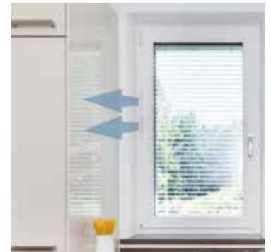
Las ventanas totalmente estancas pueden causar la formación de moho, especialmente en viviendas antiguas. El dispositivo de ventilación limitada o un aireador puede regular la ventilación sin apenas pérdida de energía.
