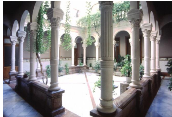
10. Patio del fondo con corredor claustro
